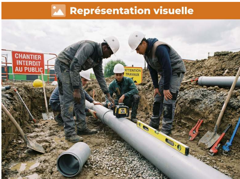
Pose de tuyaux PVC DN200 avec une pente de 0,5% pour assurer un drainage efficace
