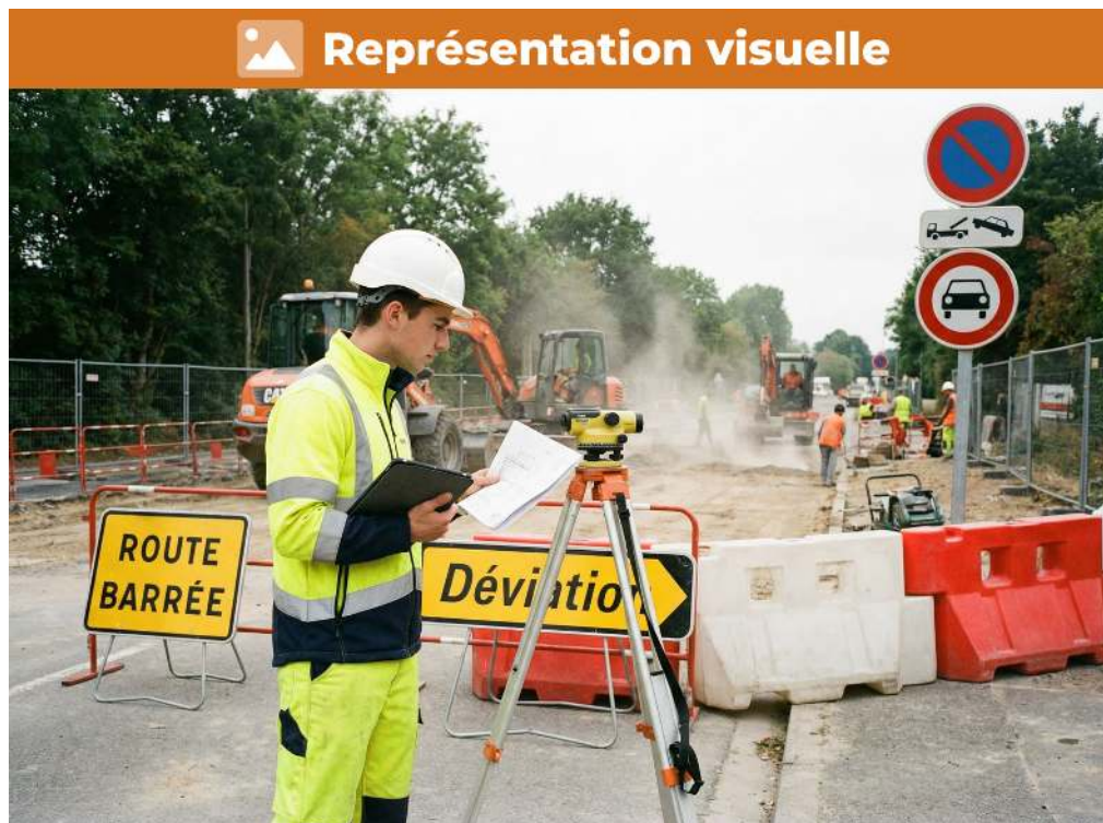
Vérification de l'implantation de panneaux de signalisation, distance de 150 mètres pour sécurité
