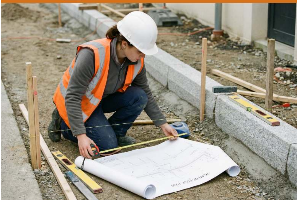
Implantation de bordures sur trottoir, vérification des cotes avec plan à l'échelle 1/200
