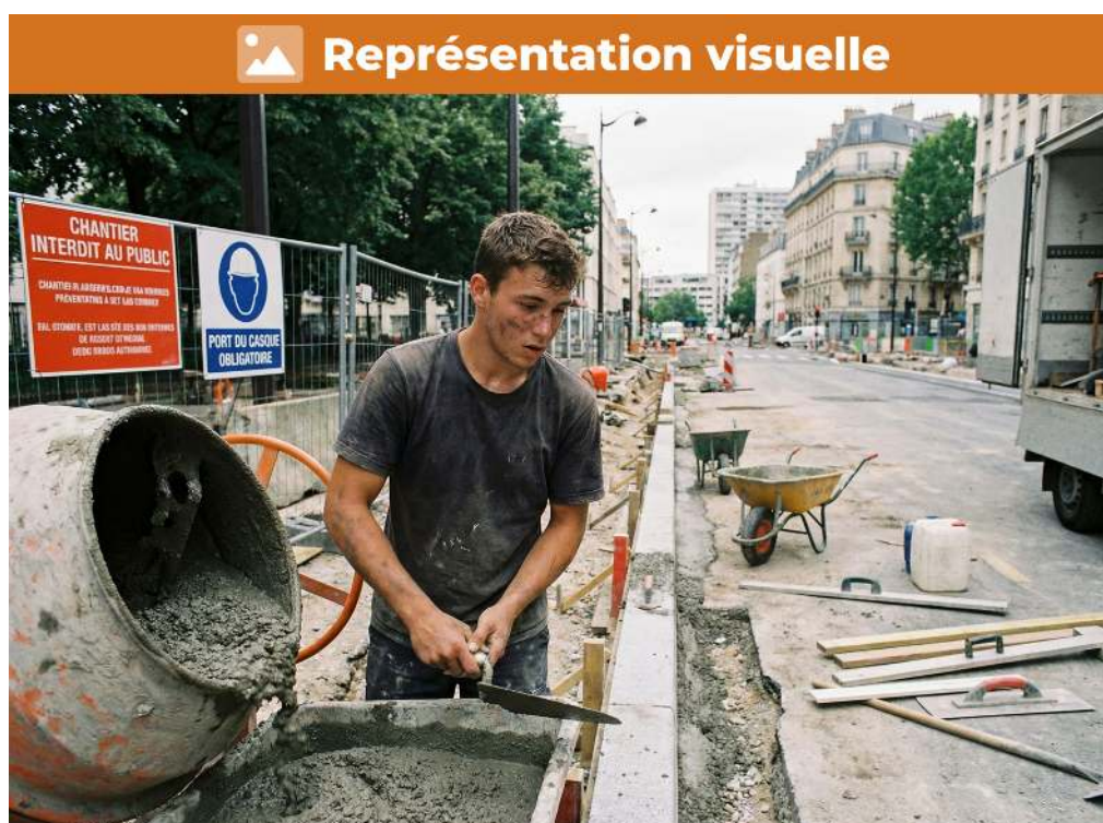
Coulage de béton pour bordures, volume de 0,25 m 3 pour une pose de 12 bordures
