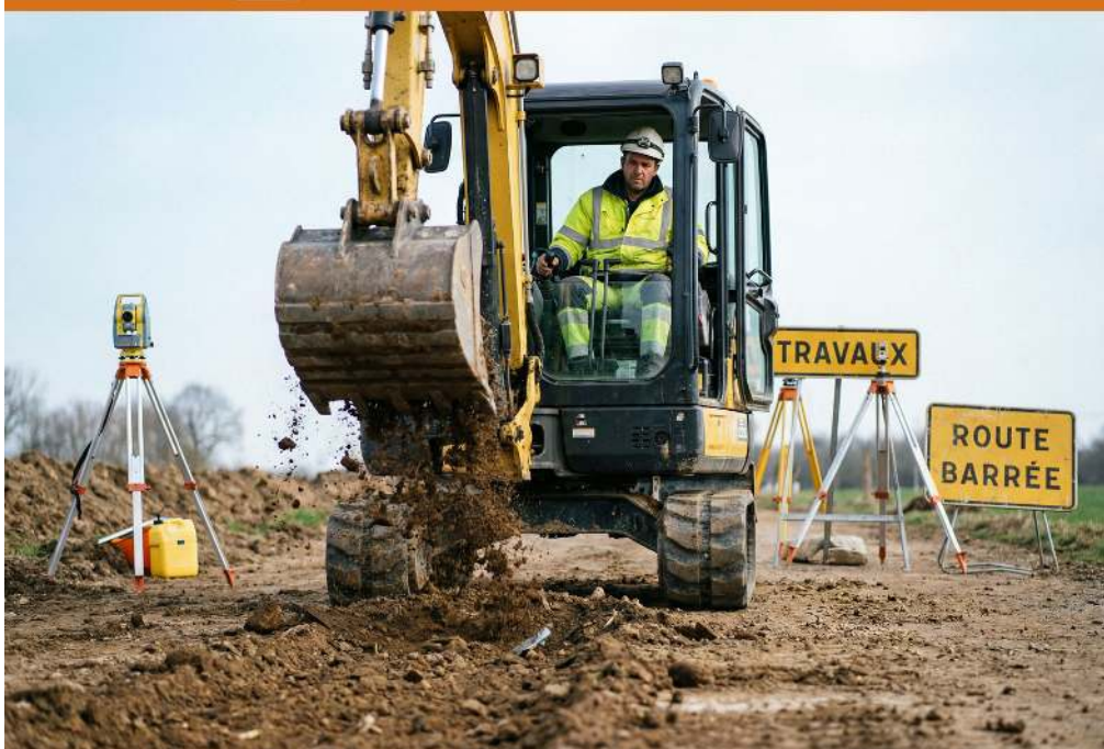
Décapage en vue avec la pelle mécanique sur un chantier, profondeur de 20 cm conforme aux normes
