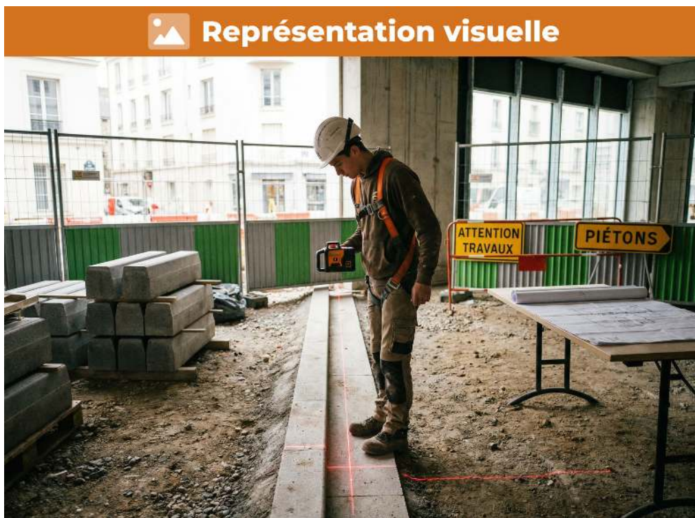
Utilisation d'un laser de nivellement pour la précision d'implantation, tolérance de 2 cm
