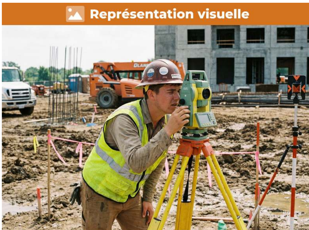
Relevés topographiques précis avec station totale, vérification des axes et niveaux sur 100 m
