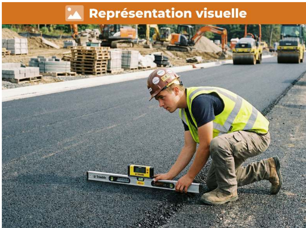
Vérification de la pente à 2% pour drainage, mesure précise avec un niveau à bulle électronique
